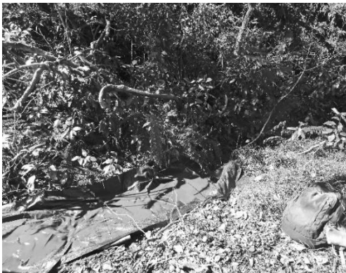
⑤排水が湿地へ流れ出ないようにシートを敷く
