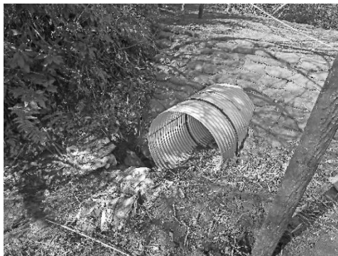
② 水路に設けられた新しいヒューム管
