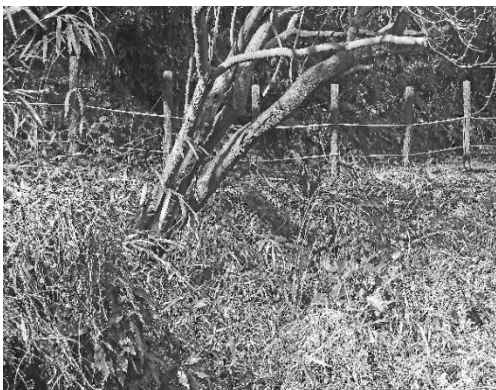
① 散策路の手すり
