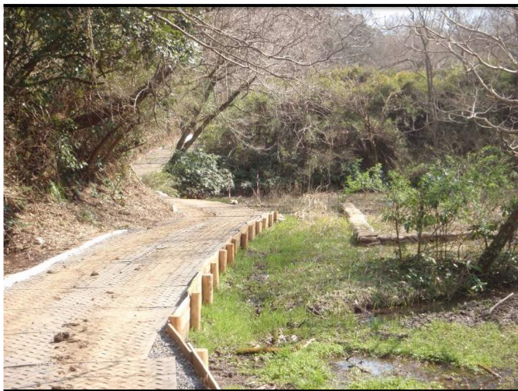
<敷設された仮設路>
