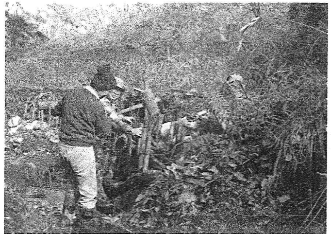
水路の路肩整備
